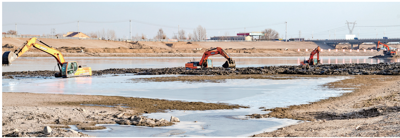
这是新绛县汾河治理PPP项目现场1月5日施工时情形。自去年汾河新绛段安全度汛后，该
