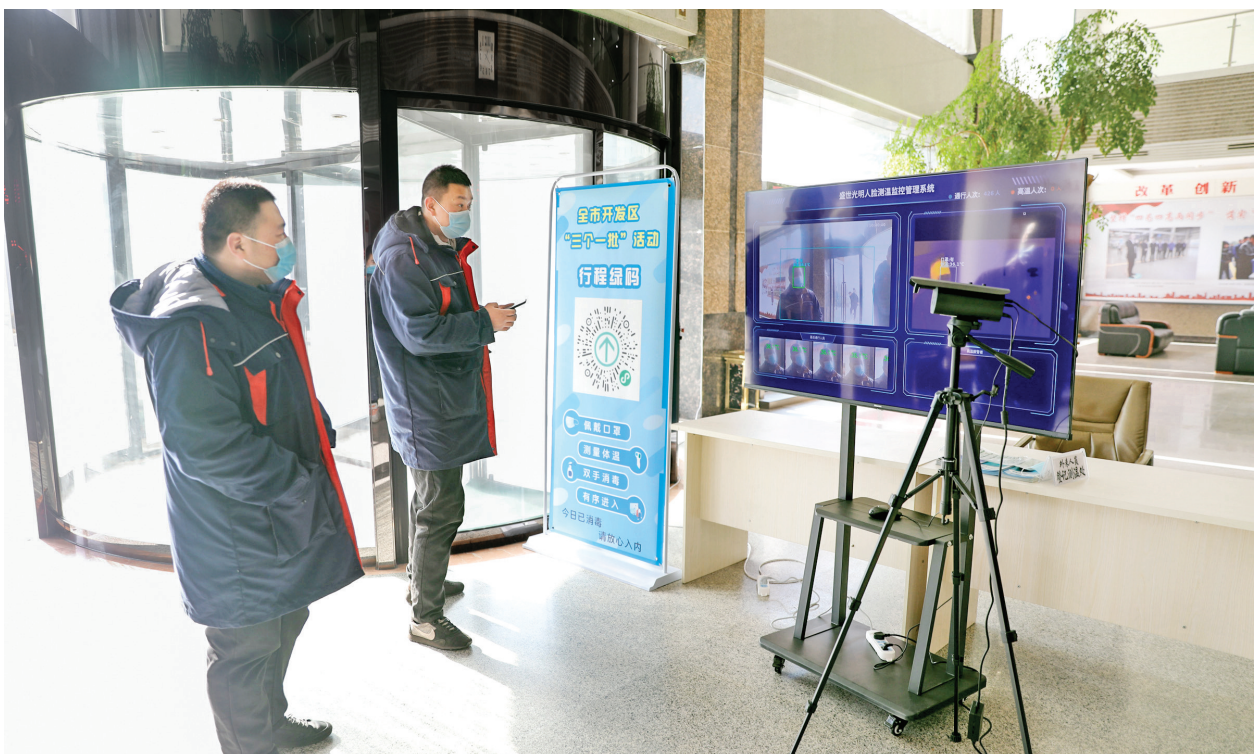
1月13日,北京盛世光明集团运城分公司工作人员在安装调试智能热成像测温仪。
