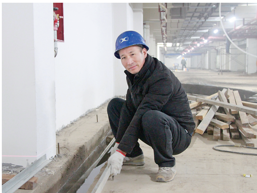
焦武斌在项目工地干活 (资料图片)
