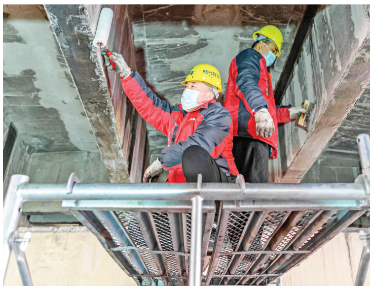
近日,工人在市中心城区圣惠路高架桥加固工程项目工地上施工。圣惠路高架桥加固工程是我市重点项目之一,春节以来,工人“就地过年”,坚守岗位,全力推进工程进度,确保5月份正常通车。 特约摄影 姜桦 摄
