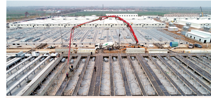
永济市牧原生猪养殖基地建设项目现场
