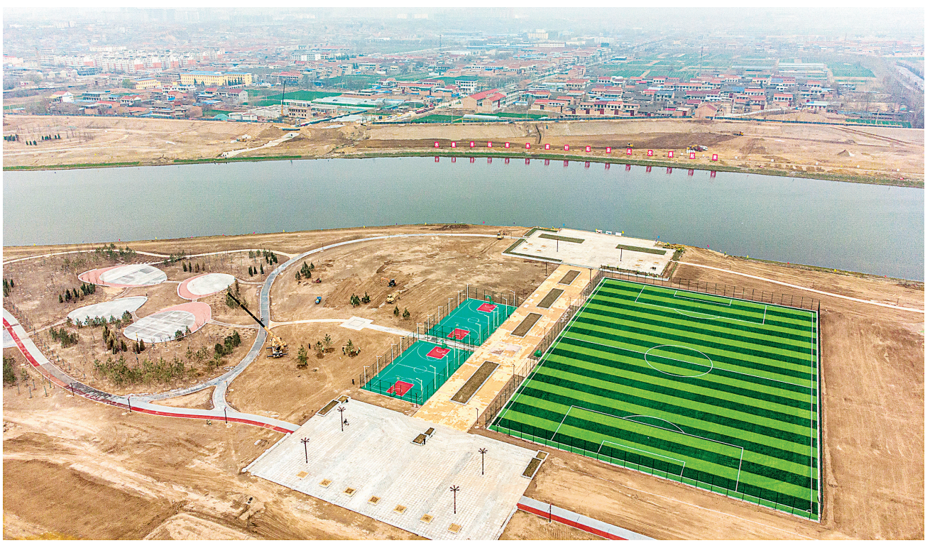
3月9日，即将完工的汾河流域新绛城区段综合治理工程(无人机拍摄)。 本报记者 雷哲侠 闫鑫 摄
