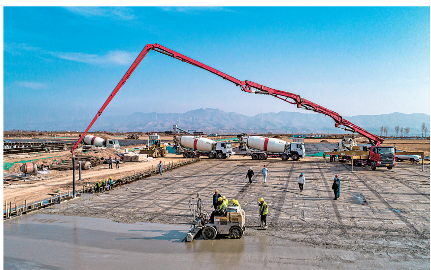
下图:3月12日,绛县东方希望畜牧有限公司坡底育肥场项目建设现场,工人在紧张施工。本报记者 金玉敏 摄
