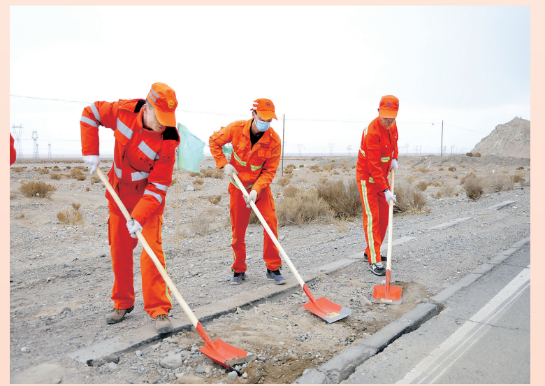
格尔木公路段养路工人在修整路肩(2月25日摄)。
