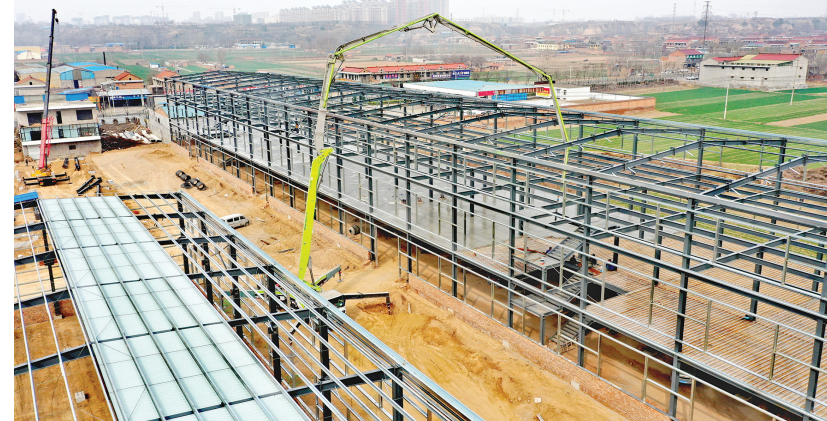
▲新绛县电子商务及智慧产业物流园项目
