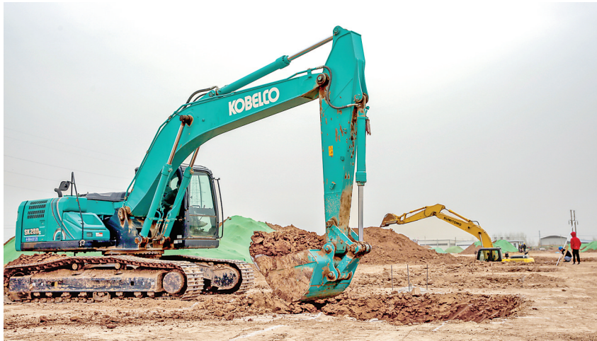
3月17日，运城经济技术开发区山西北铜新材料科技有限公司高性能压延铜带箔和覆铜板项目工地，大型机械在施工作业。 本报记者 金玉敏 摄
