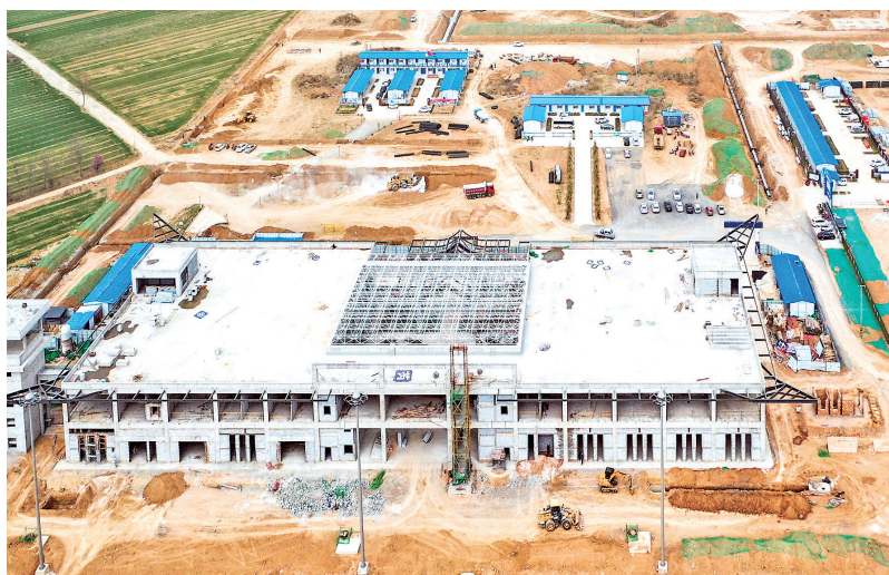
▲芮城通用机场项目
