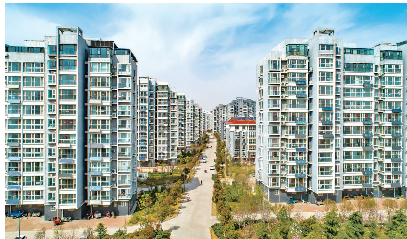
这是3月24日拍摄的山东省临沂市莒南县坪上镇房家寨村新社区(无人机照片) 新华社发(孙运亮 摄)
