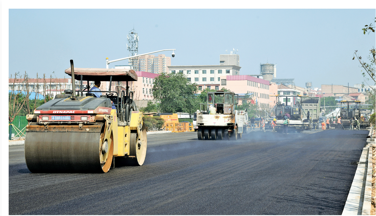
闻垣路县城段改造工程是闻喜县2021年城市建设重点工程之一，筑路工人在保障工程质量的前提下，加班加点施工，确保工程如期竣工。图为6月2日，工人在闻喜县闻垣路县城段铺设路面。 特约摄影 温徐旺 摄
