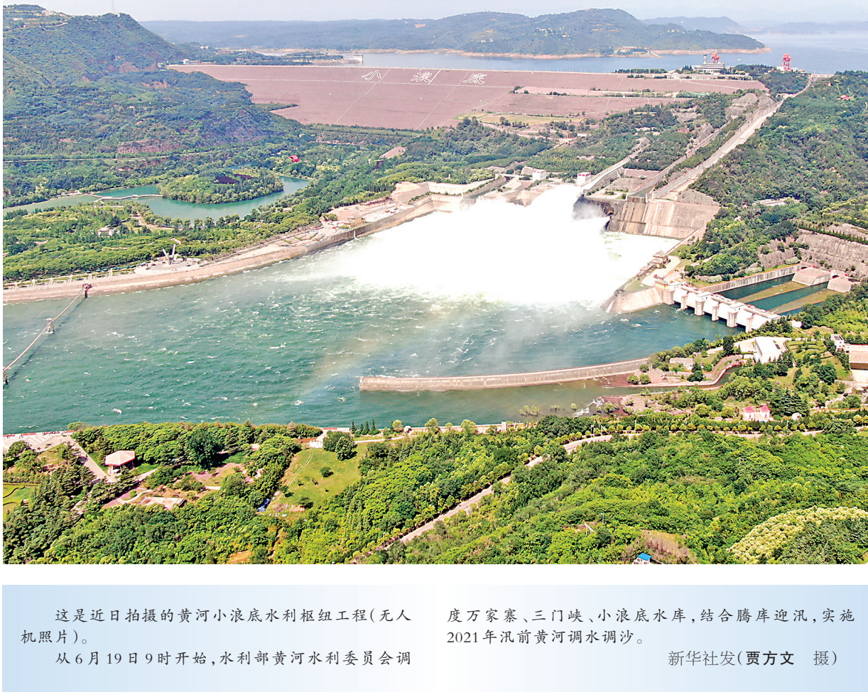
这是近日拍摄的黄河小浪底水利枢纽工程(无人飞机照片)。从6月19日9时开始,水利部黄河水利委员会调度万家寨、三门峡、小浪底水库,结合腾库迎汛,实施2021年汛前黄河调水调沙。新华社发(贾方文 摄)
