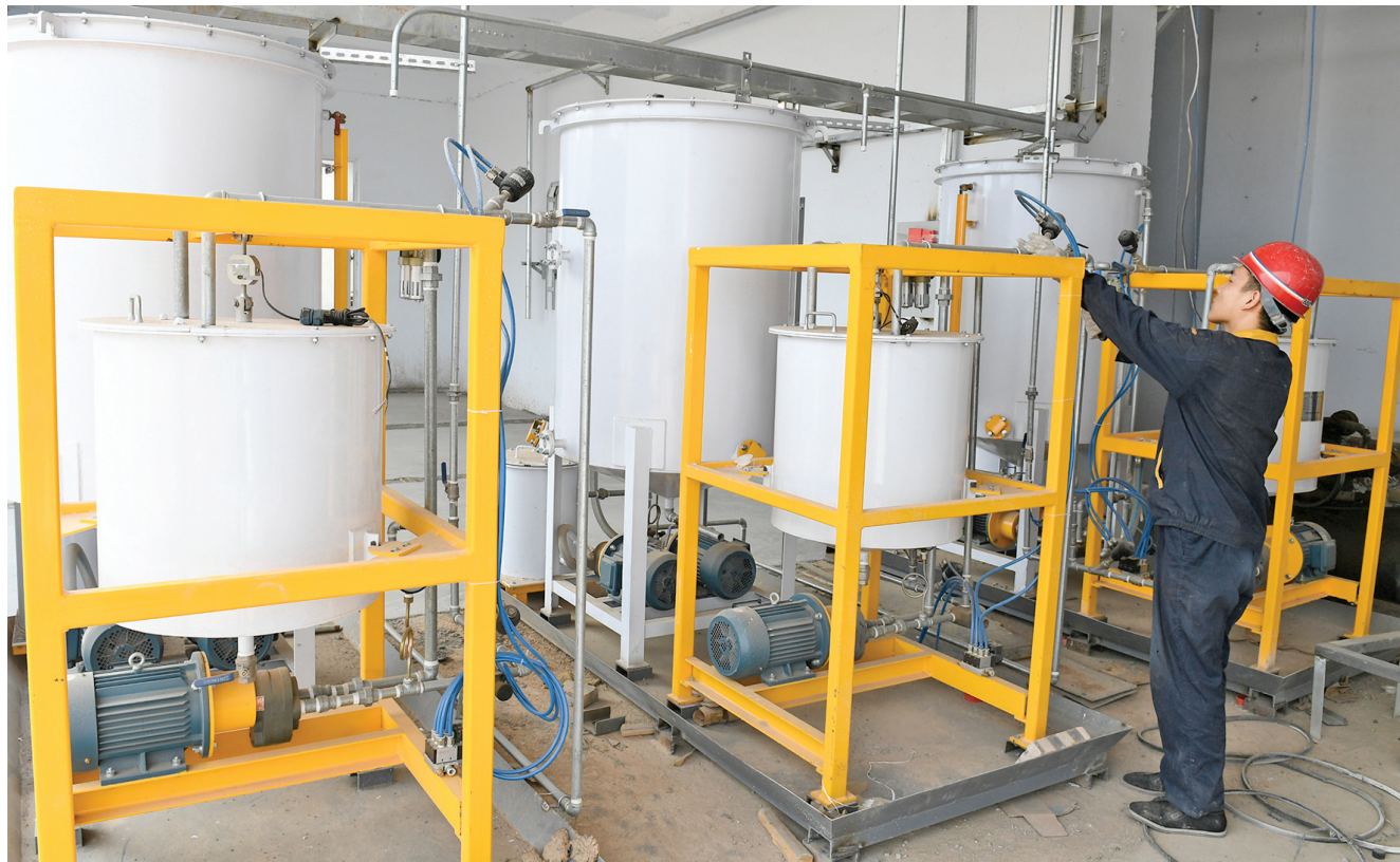
8月17日，稷山经济技术开发区山西晋龙集团20万吨级自动化饲料生产线项目施工现场，工人在安装调试设备。该公司投资1.2亿元建设一条年产20万吨自动化饲料生
