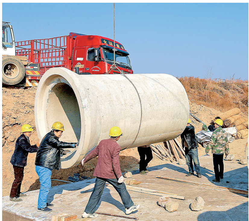
12月13日,施工人员在夏县青龙河实施水毁漫水桥修复工程。今年10月份,夏县遭受历史罕见的连阴雨,青龙河洪峰持续暴发,导致尉郭乡西董村至禹王青台、白张村至郭里村两处漫水桥损毁。为方便村民安全出行,该县交通运输局精心安排部署,实施水毁漫水桥修复工程,力争在2022年春节前竣工通车。特约摄影 张秀峰 摄
