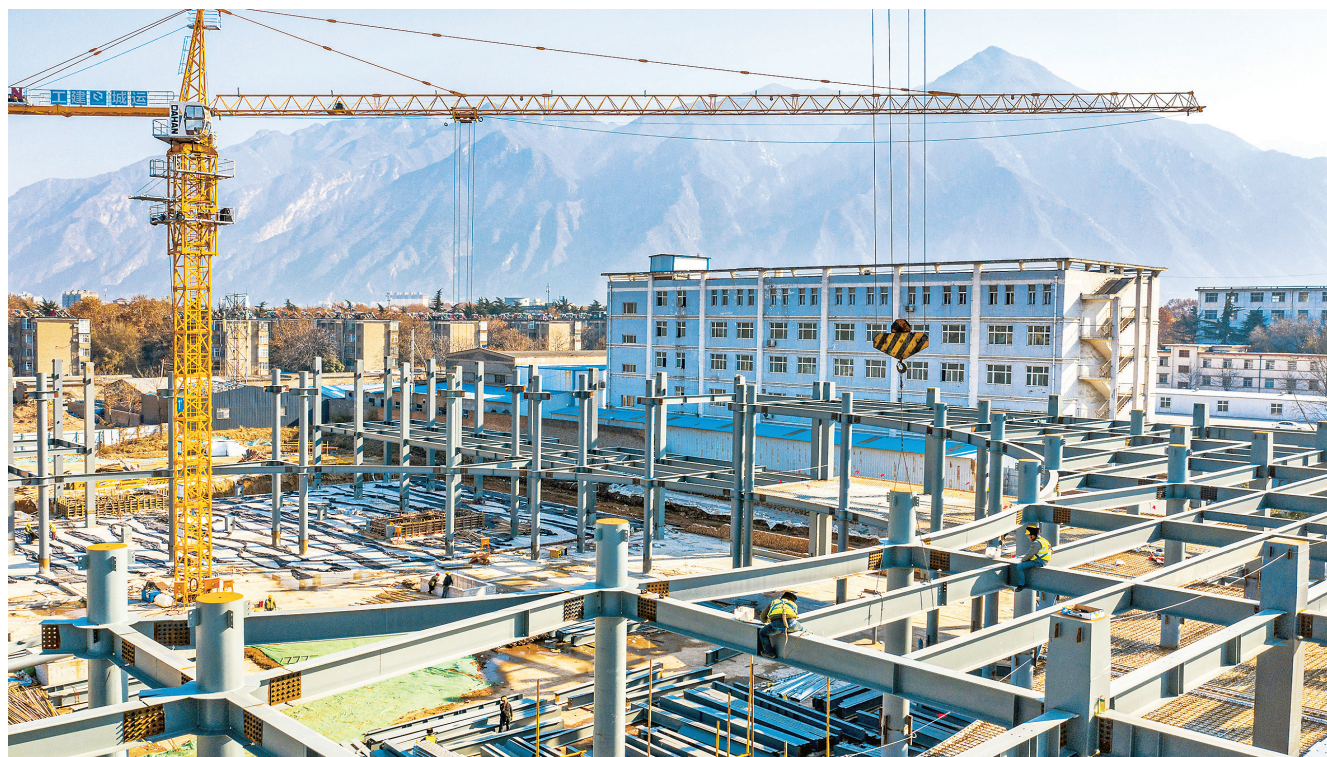
12月14日，永济市政服务中心及人防工程建设工地，工人在紧张施工。
