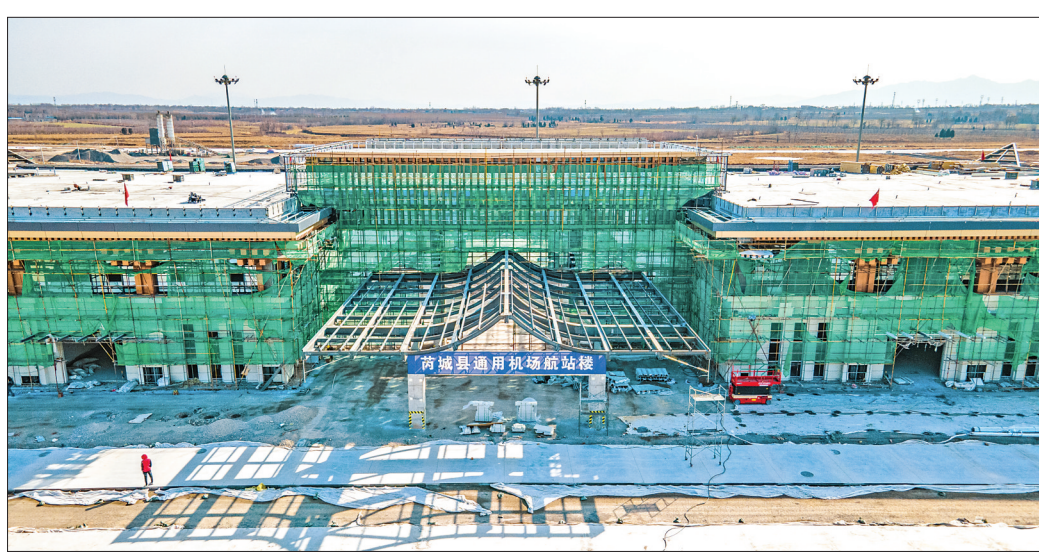
寒冬时节,芮城县通用机场项目建设如火如荼(12月15日摄)。 该项目采取政府主导的方式,按照“超前规划、科学布局、分步实施”的原则有序推进。工程总投资3.5亿元,占地面积848.78亩,按照通用机场A1类标准建设。 本报记者 陈方斌 摄
