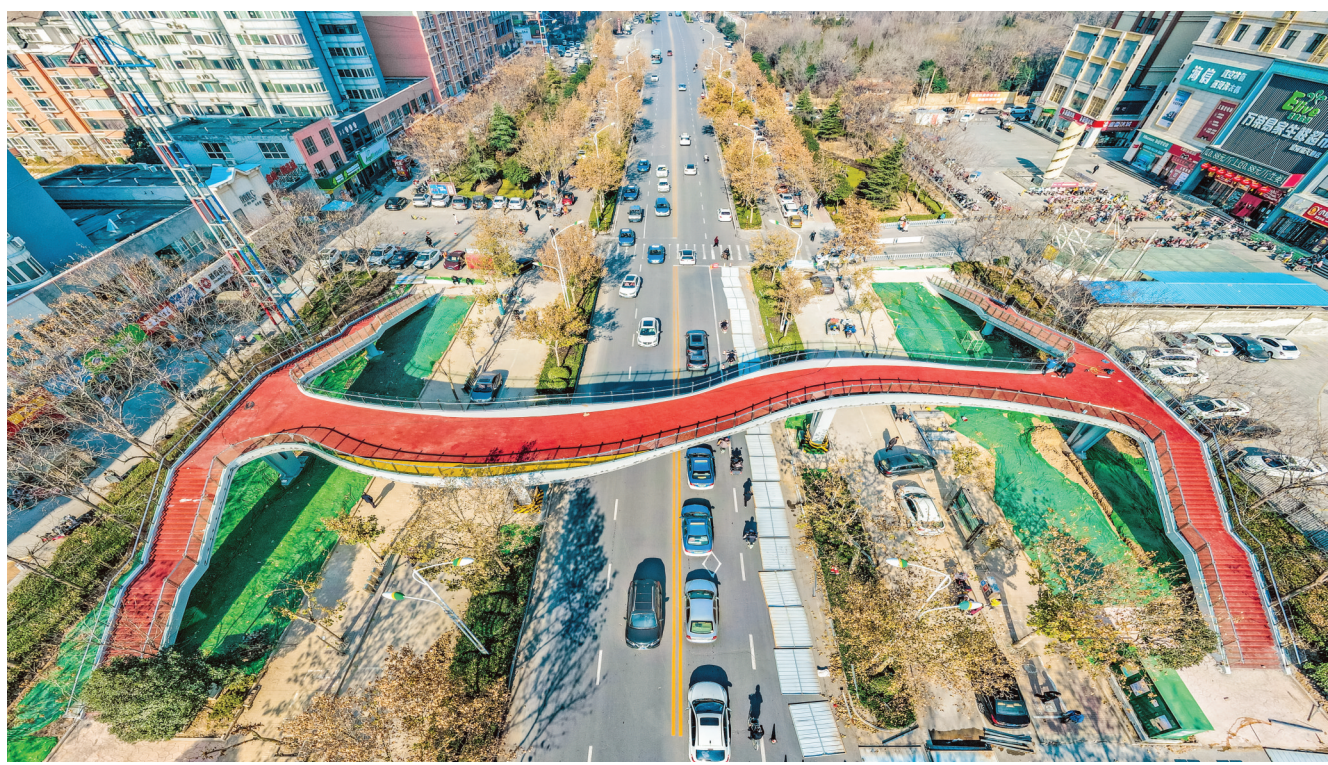
12月20日,中心城区人民北路眼科医院人行天桥建成并投入使用。该天桥主梁采用连续变宽整体式钢箱梁,跨径55.01米,梁高0.8米,主梁宽4.82米—6.93米,下部采用钢结构“Y”型桥墩。
