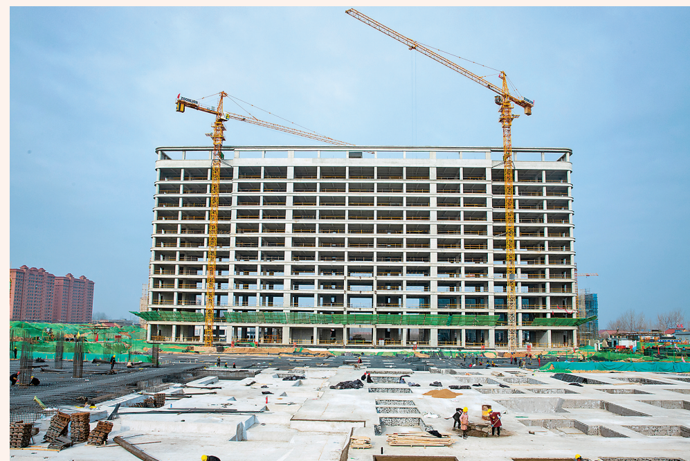
1月7日,夏县人民医院迁建项目工地,工人在确保疫情防控安全的前提下,有序施工。夏县人民医院迁建项目是夏县2021年重点工程项目,建成后将有效解决当地群众“看病难、看病贵”问题。特约摄影 姚中吉 摄
