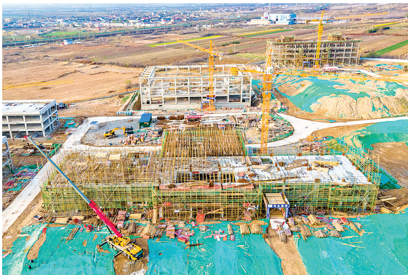
建设中的运城市综合训练基地(3月15日摄)。 该项目规划用地面积约13.8万平方米,总建筑面积27.8万平方米,总投资1.8亿元,主要分训练演练区、消防应急训练区、教学培训区、救灾物资储备库区和生活保障区5个功能区
