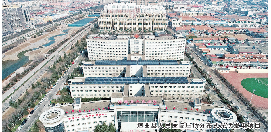
垣曲县人民医院屋顶分布式光伏发电项目
