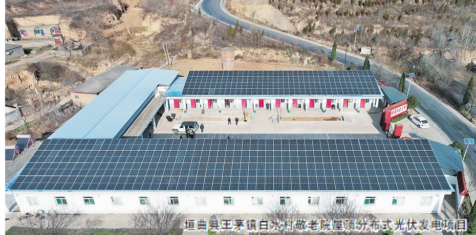
垣曲县王茅镇白水村敬老院屋顶分布式光伏发电项目
