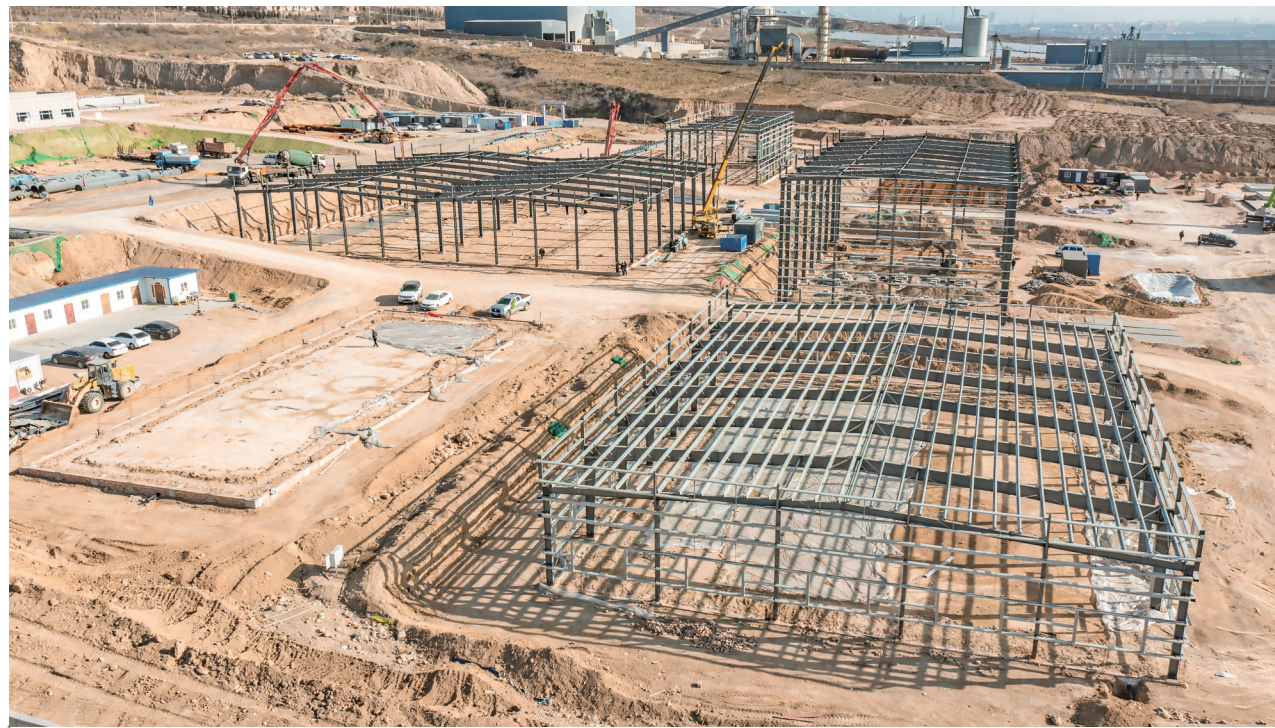
正在建设中的河津市山西鹤龙精细化工年产18800吨高纯度对甲酚项目(3月21日摄)。该项目是我市“1311”重大工程项目,主要建设磺化车间、中和酸化车间、磺化车间等主体以及相关配套公共施工程。项目完工后可达到节能降耗降低能耗的目的。本报记者 陈方斌 摄
