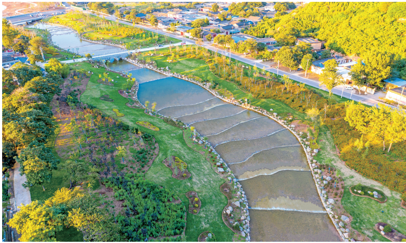
位于盐湖区解州镇南部中条山脚下的五龙峪河道综合治理项目,是关公故里旅游景区的重要组成部分,通过对五龙峪桥至西碾湖水库的河道实施生态综合治理和景观提升,打造水清岸绿景美的亮丽风景线。 本报记者 闫鑫 摄
