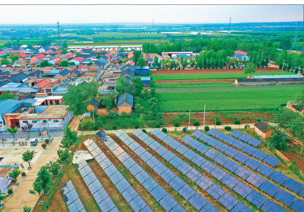
近日,夏县南大里乡北大里村光伏发电场上,一排排单晶硅板在太阳光的照耀下,源源不断地转换成绿色清洁能源。
