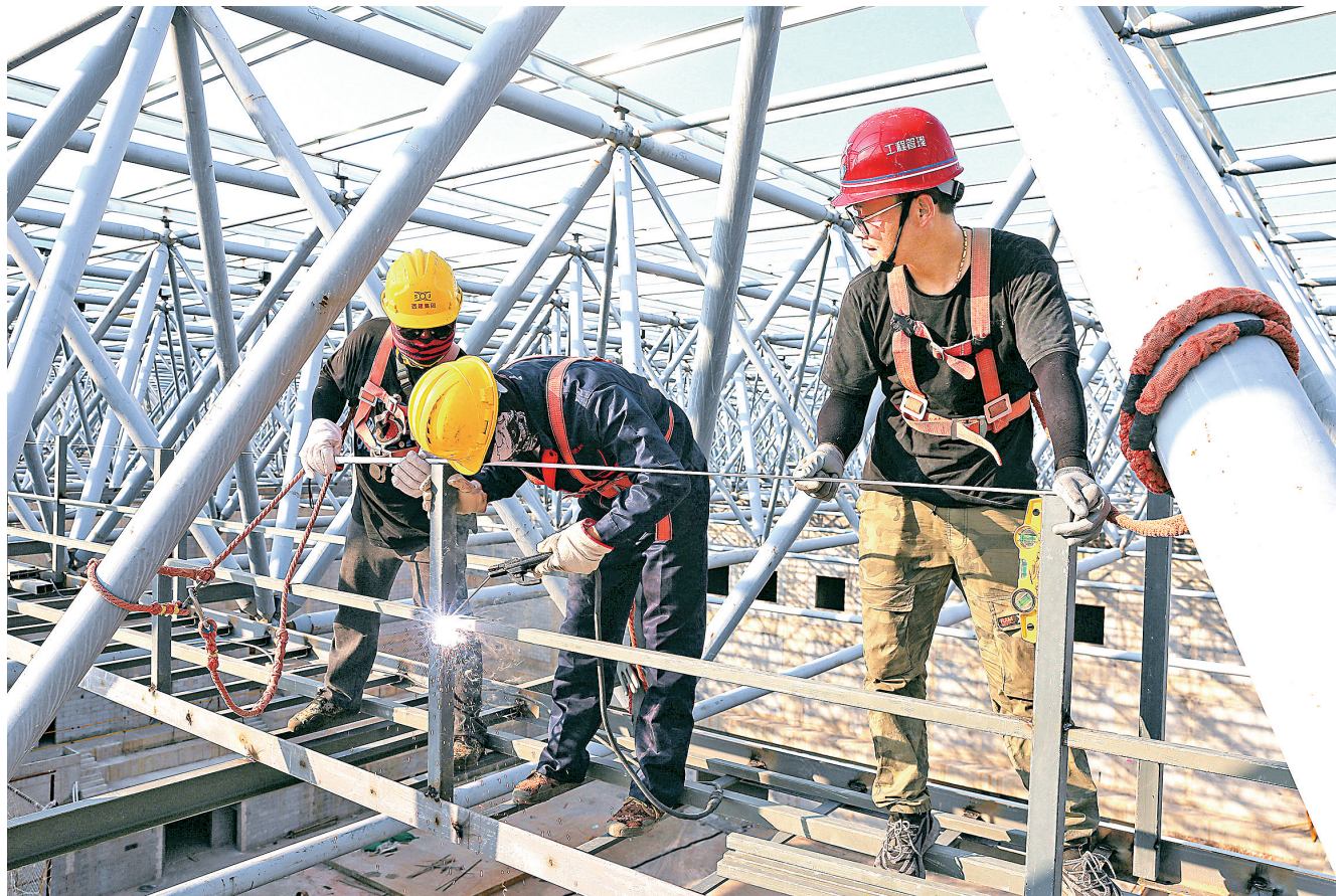
6月20日,夏县夏都体育中心建设工地,施工人员进行网架索道焊接作业。
