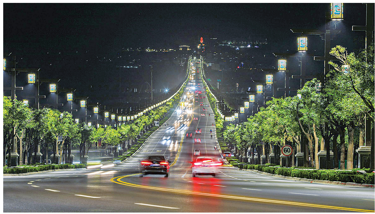
9月6日,市民驾车行驶在复铺完工的跨湖大道上。近日,中心城区跨湖大道池神庙盐化铁路路口至凤凰森林公园路面提升工程完工并投入使用,道路两侧的新型节能LED“运”字路灯也更更换到位,夜幕降临,华灯绽放,恰如珍珠贯穿盐池,美不胜收。
