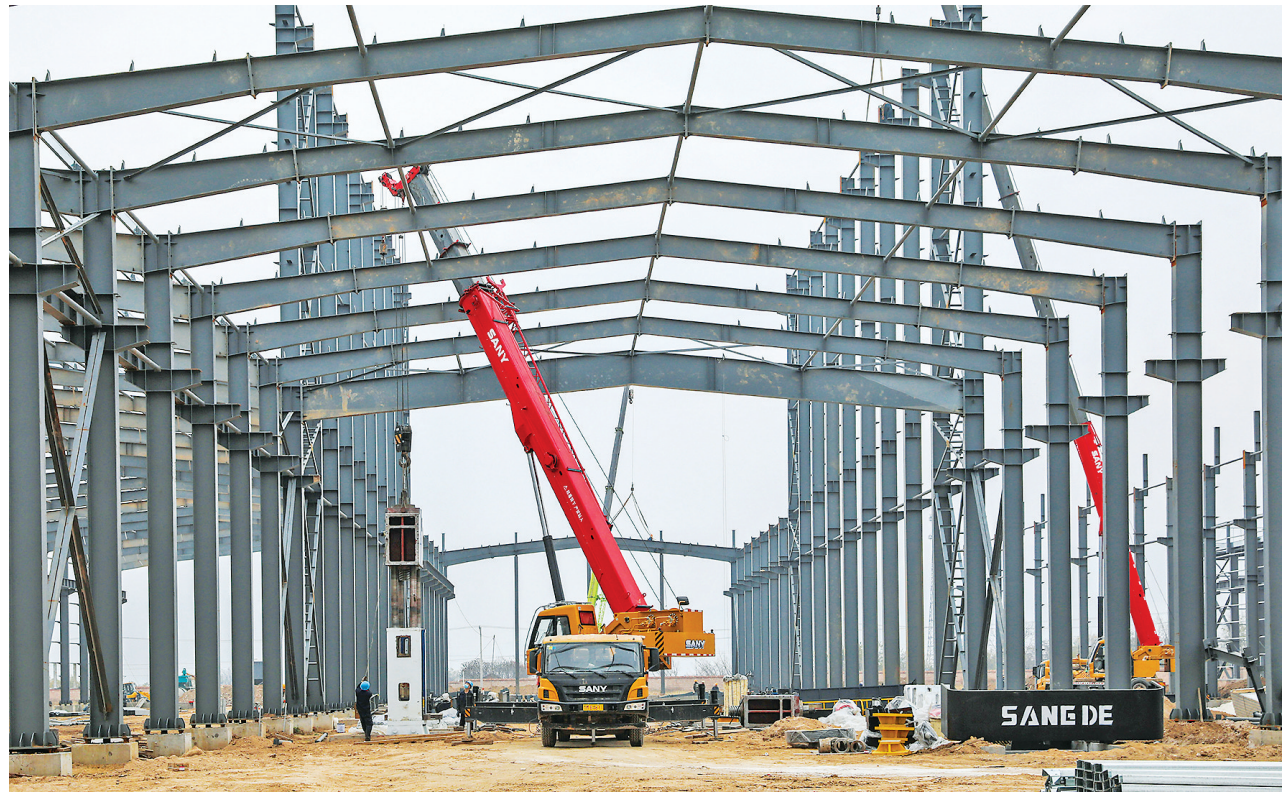
11月18日,绛县开发区山西皓昆新材料科技有限公司年产12万吨耐火材料项目工地,工人们在加紧建设。近年来,绛县开发区严格落实包联
