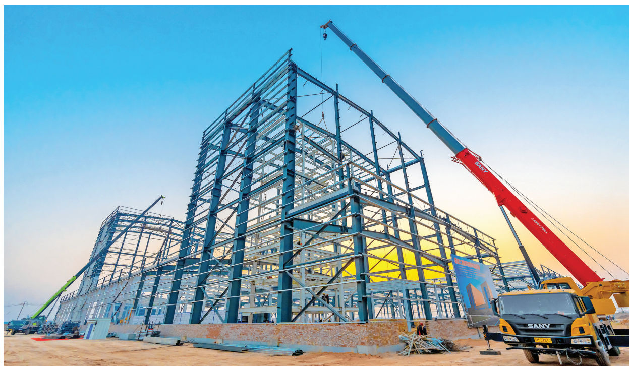
12月5日，施工人员在芮城县山西大禹生物工程股份有限公司基因工程酵母菌体免疫项目建设现场吊装构件。
