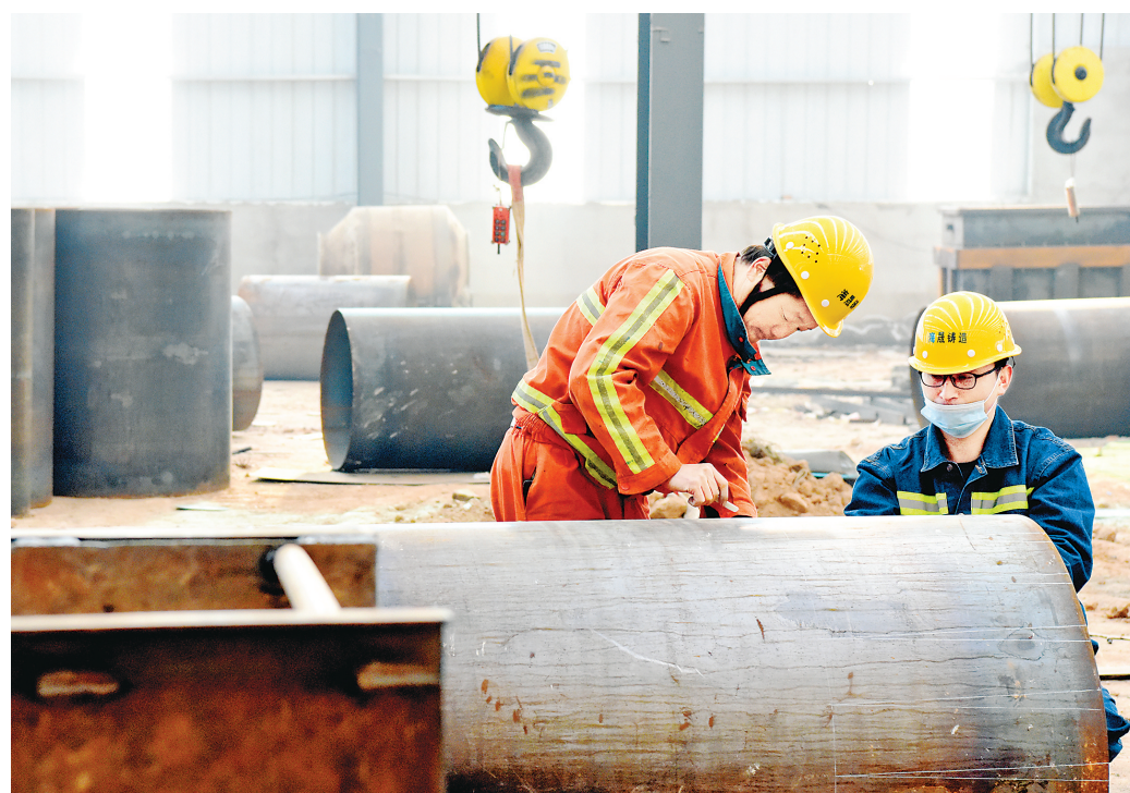
12月27日，在垣曲经济技术开发区海晟科技公司，技术人员在安装设备，争取使这一高强度耐磨合金钢产品项目早日投产。连日来，该开发区里的5个在建项目加快复工步伐，精心统筹安排，力争早日投产。 特约摄影 崔松良 摄
