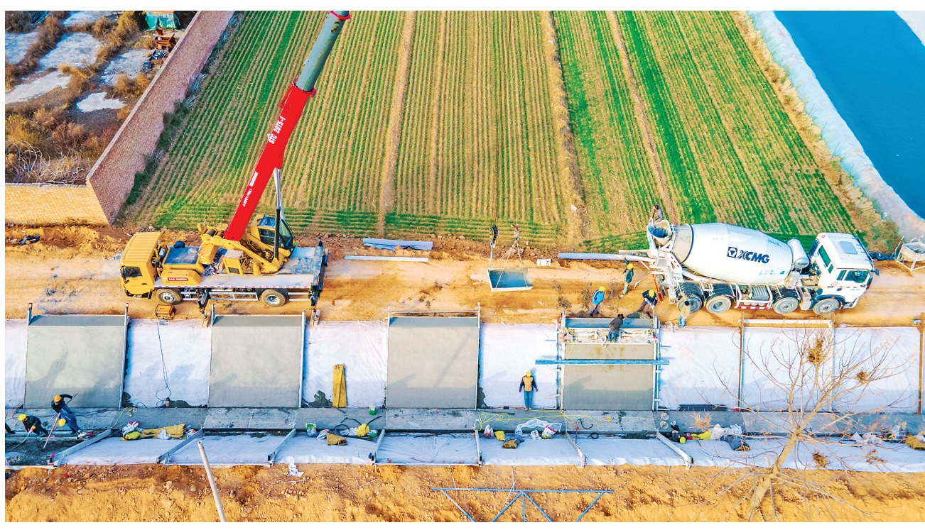
大高渡灌区“十四五”续建配套与现代化改造项目是市“1311”重大工程项目，总投资2.8479亿元，建成后可改善灌溉面积29.12万亩。图为近日拍摄的大高渡总干渠改造项目施工现场。 本报记者 陈方斌 摄
