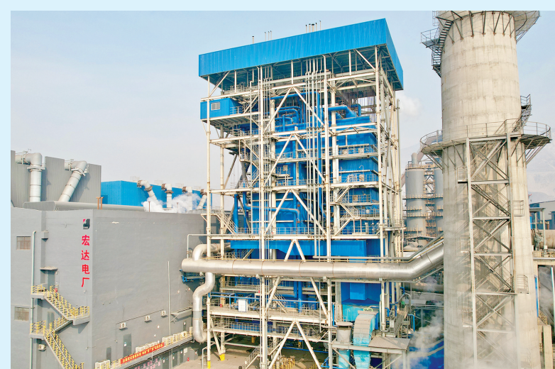
河津市：山西宏达钢铁集团有限公司100兆瓦超高温亚临界煤气发电项目
