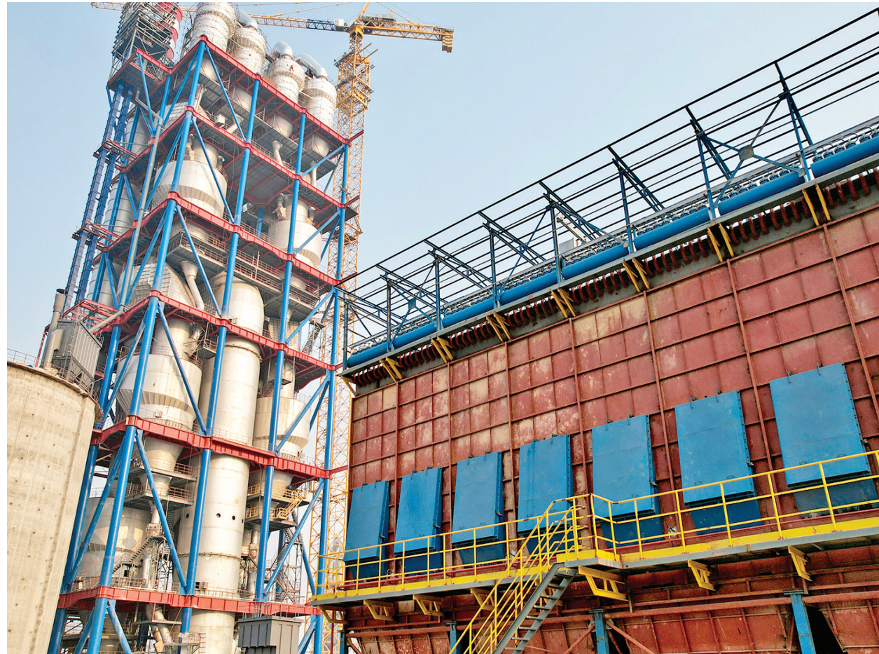
2月6日,新绛县威顿水泥集团有限责任公司数字化智能化绿色工厂技术改造项目在加紧施工。该项目采用新型干法绿色生产技术,产品广泛应用于高速铁路、高速公路、
