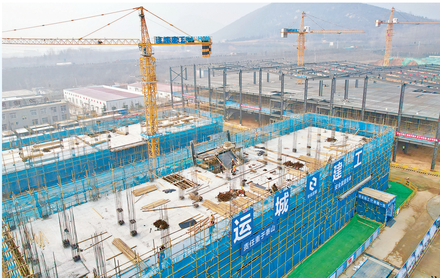
▲垣曲县:垣曲经济技术开发区创业创新孵化中心项目
