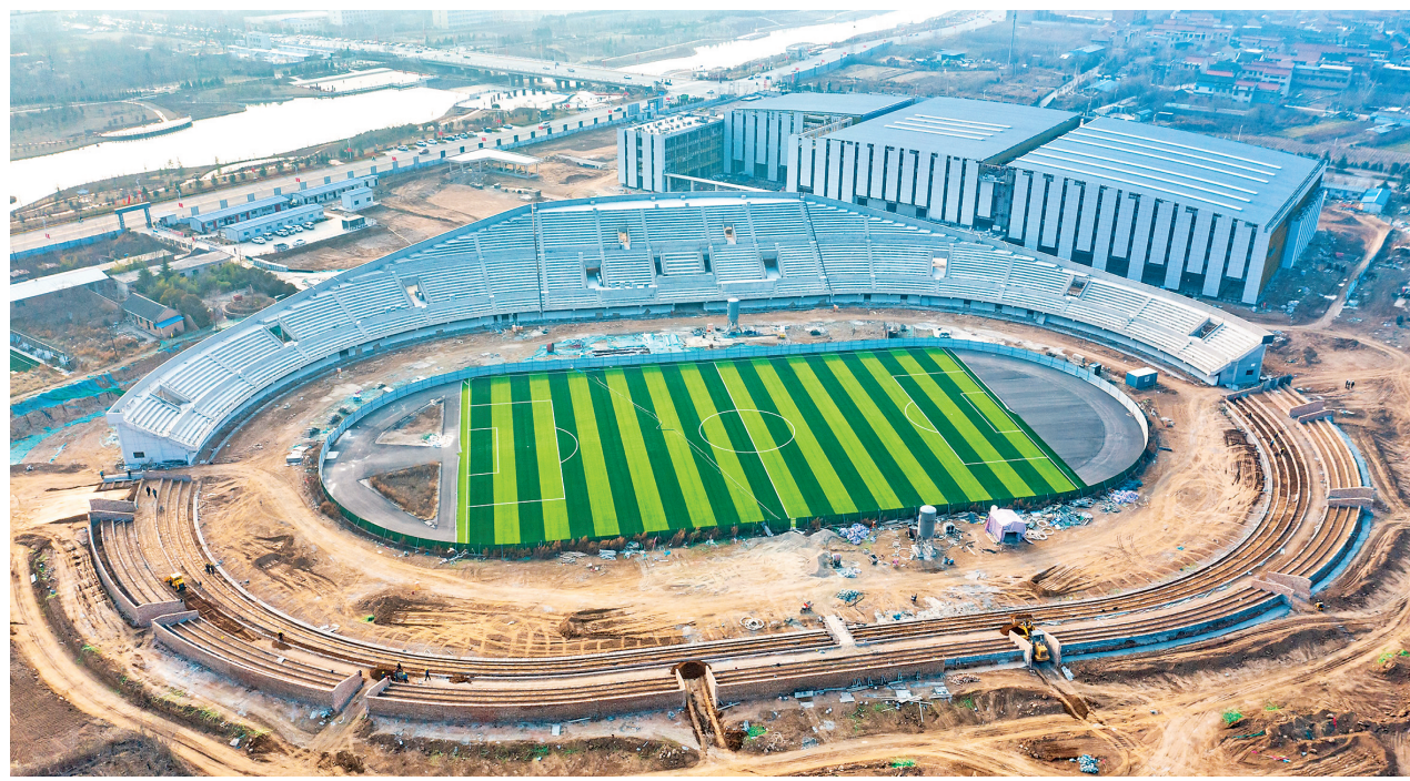
夏县夏都体育中心建设项目是全市“1311”重大工程项目,投资2.9亿余元,建筑面积47788.78平方米,建设内容分综合体育馆、体育场、室外配套工程三大板块。目前,该项目主体工程已经建设完工。图为记者2月24日拍摄的项目建设现场。本报记者 陈方斌 摄
