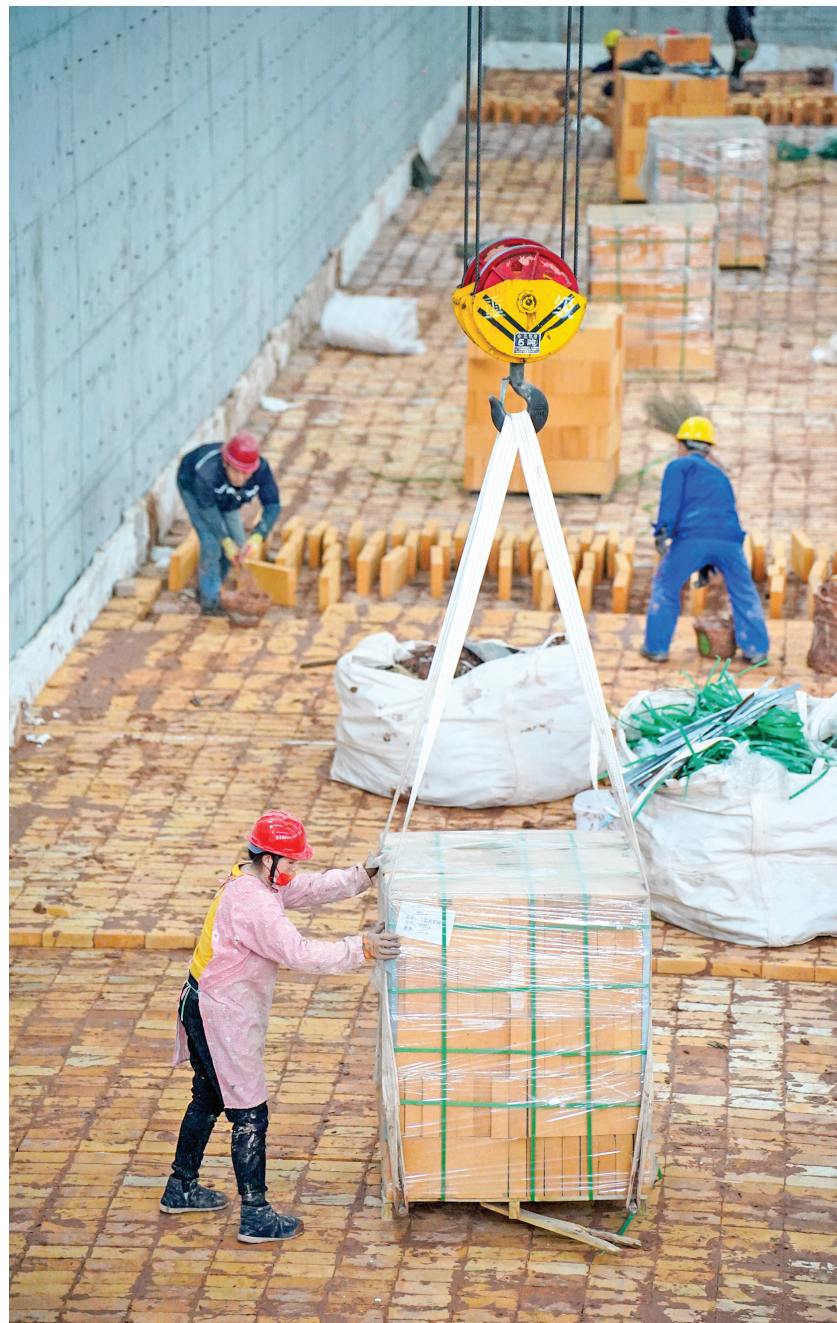
山西博翔汇良新材料有限公司年产3万吨特种石墨项目正在建设中。
