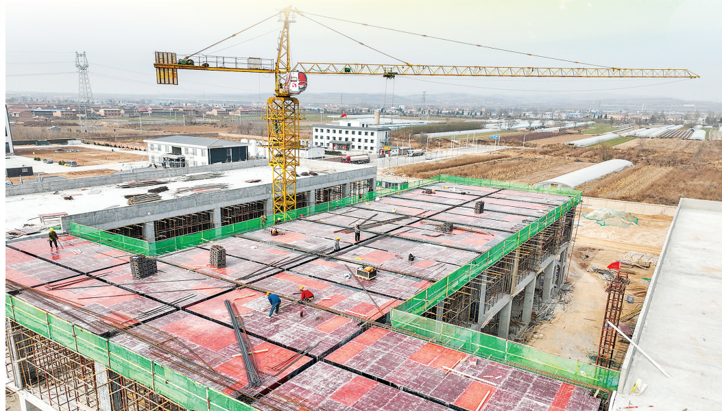
闻喜县天顺兴玻璃工艺品有限公司年产600万只耐热高硼硅玻璃制品建设项目正在加紧建设。 本报记者 金玉敏 摄
