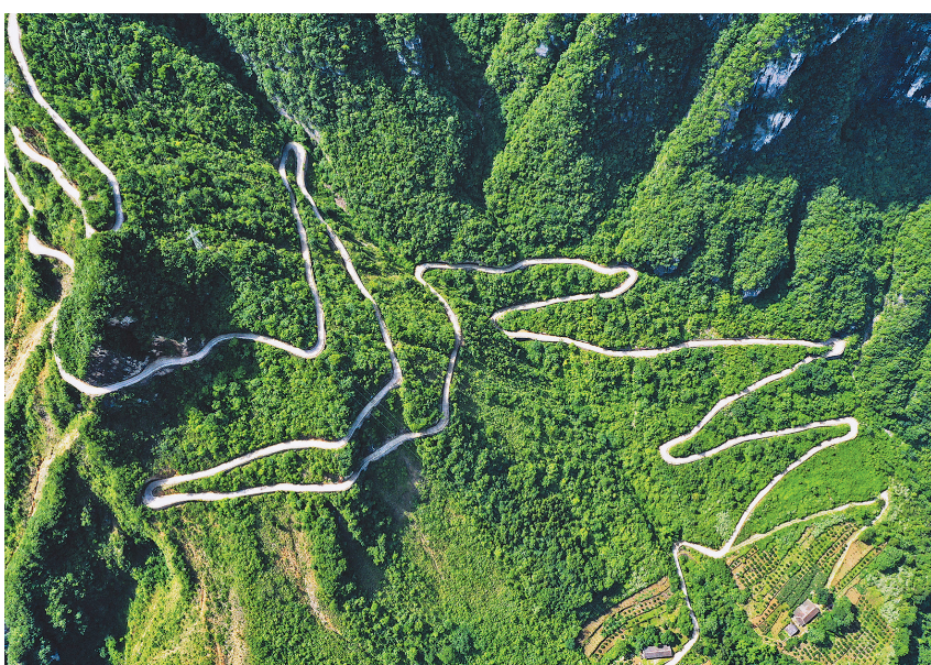
这是重庆市巫山县下庄村通往外界的公路(2020年7月3日摄，无人机照片)。
