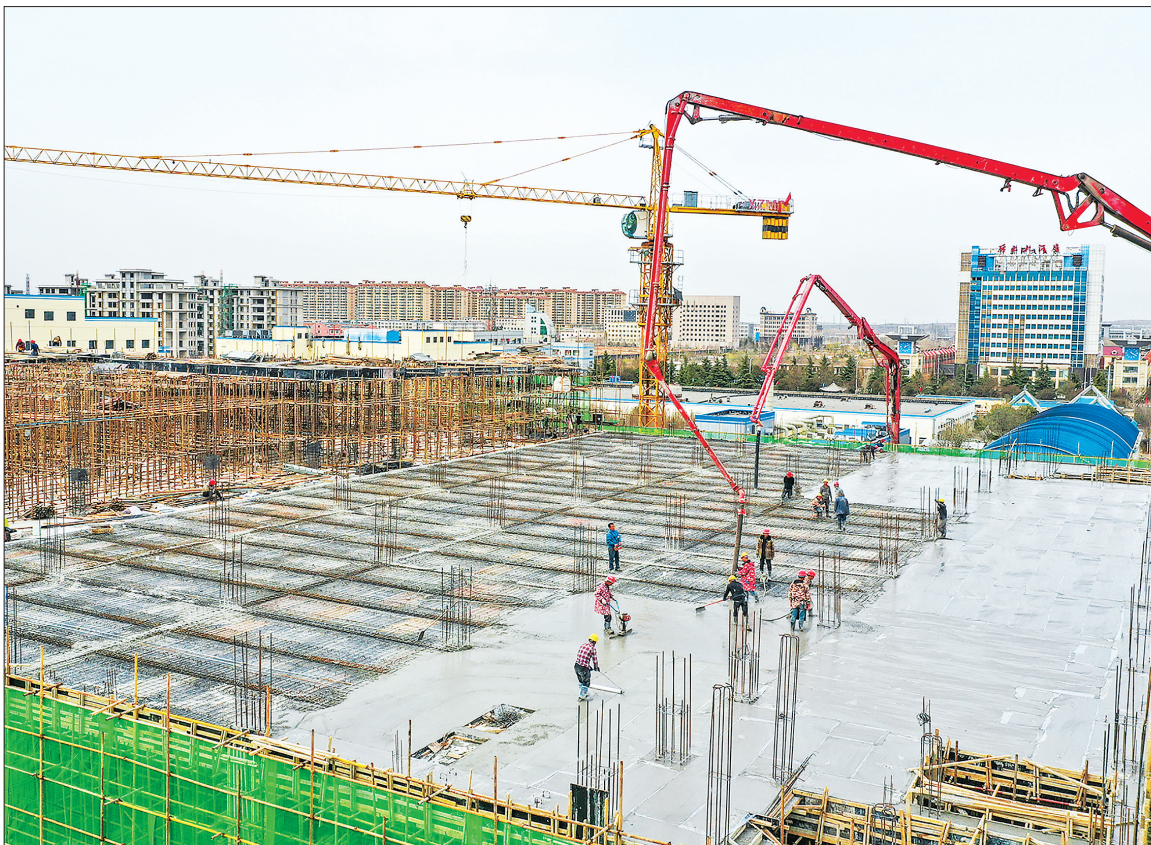
3月15日,万荣县山西华康药业有限公司前处理车间主体工程加紧施工中。该项目总投资6000万元,是万荣县“十四五”期间实施的重点工程之一,将配套安装3条现代化中药材前处理生产线,投产产能可提升一倍,预计增加年产值1.5亿元。 特约摄影 李克荣 摄
