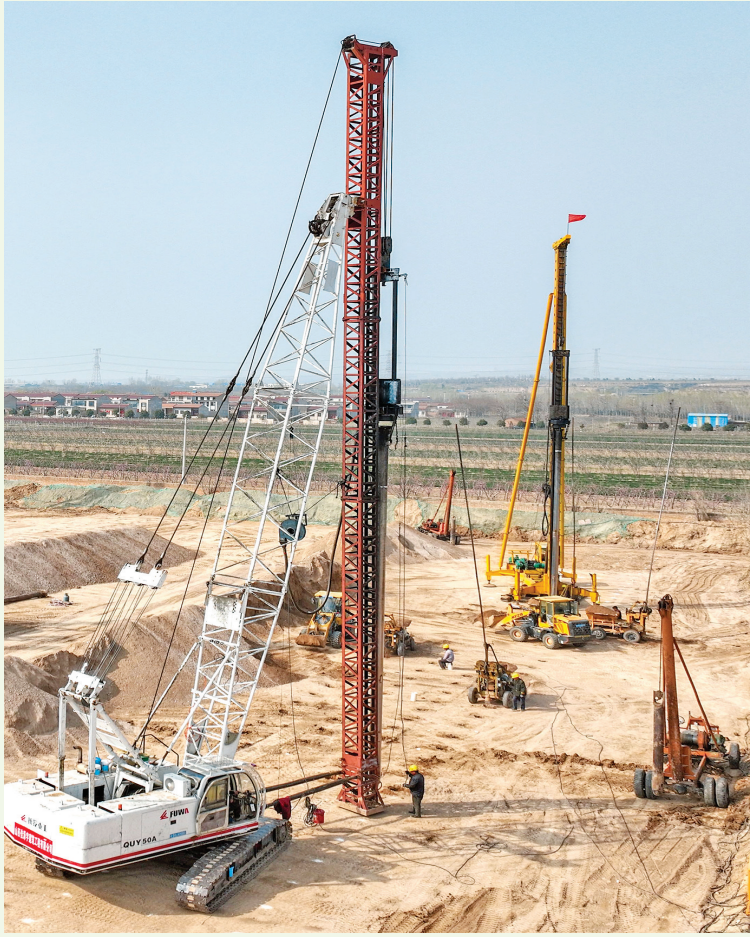
近日，山西弘美华农业科技有公司二期智能化果脯加工项目工地，工人们在加紧施工。
