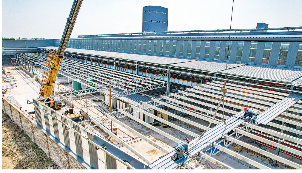
上图:天地和金属二期年产62万吨精品镀锌板带、镀锌钢管项目在有序推进中。 右上图:新绛县德鑫化工有限公司年产8万吨2,4-二硝基氯苯项目建设现场。 右下图:山西银盛精细化学品科技有限公司质检部工作人员在进行精细化检测。
