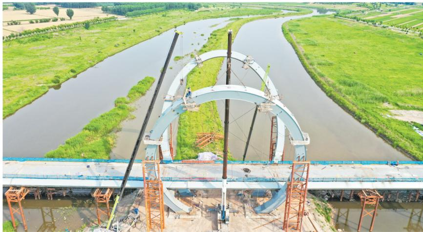
6月12日，施工人员在稷山县汾河公园桥梁工程建设现场进行主塔合龙吊索作业。
