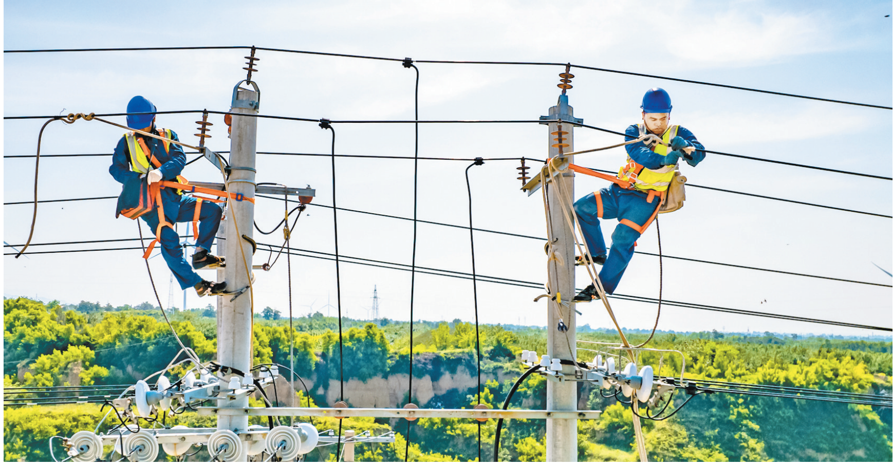
6月27日，芮城供电公司员工在检修线路。为保障群众安全、可靠、稳定用
