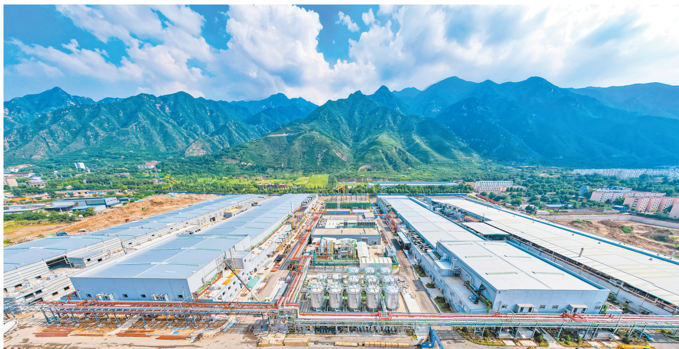
坐落于永济的山西蓝科锂动力电池隔膜二期项目施工现场（拍摄于7月4日）。
