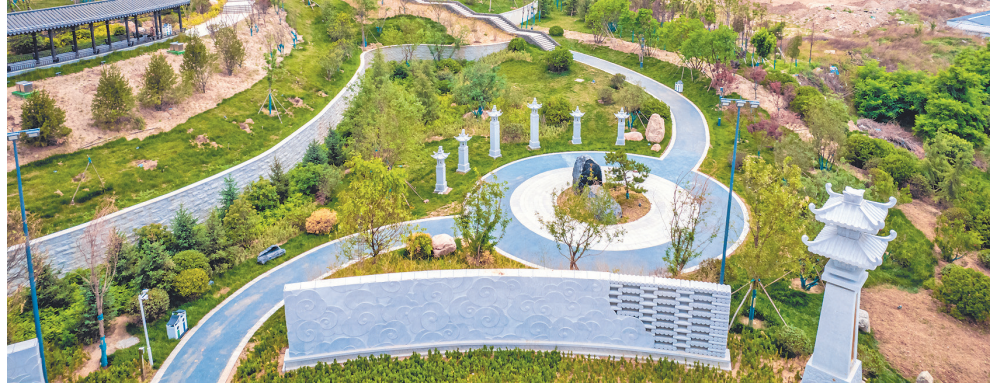
施工中的南山破山体生态修复工程现场。
