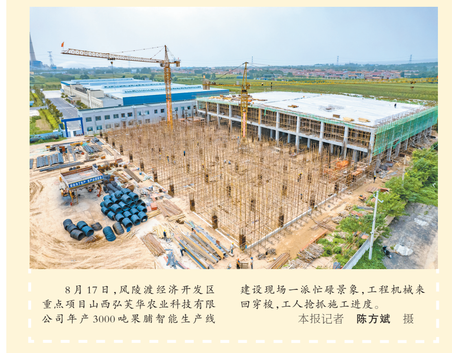
8月17日,风陵渡经济开发区重点项目山西弘英华农业科技有限公司年产3000吨果脯智能生产线建设现场一派忙碌景象,工程机械来回穿梭,工人抢抓施工进度。本报记者 陈方斌 摄
