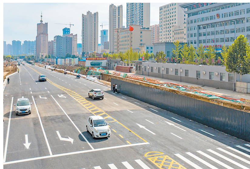
9月1日，市区魏风街(周西路至形意路)主车道通车。该道路工程全长约610米，双向四车道，红线宽46米，绿线宽66米。
