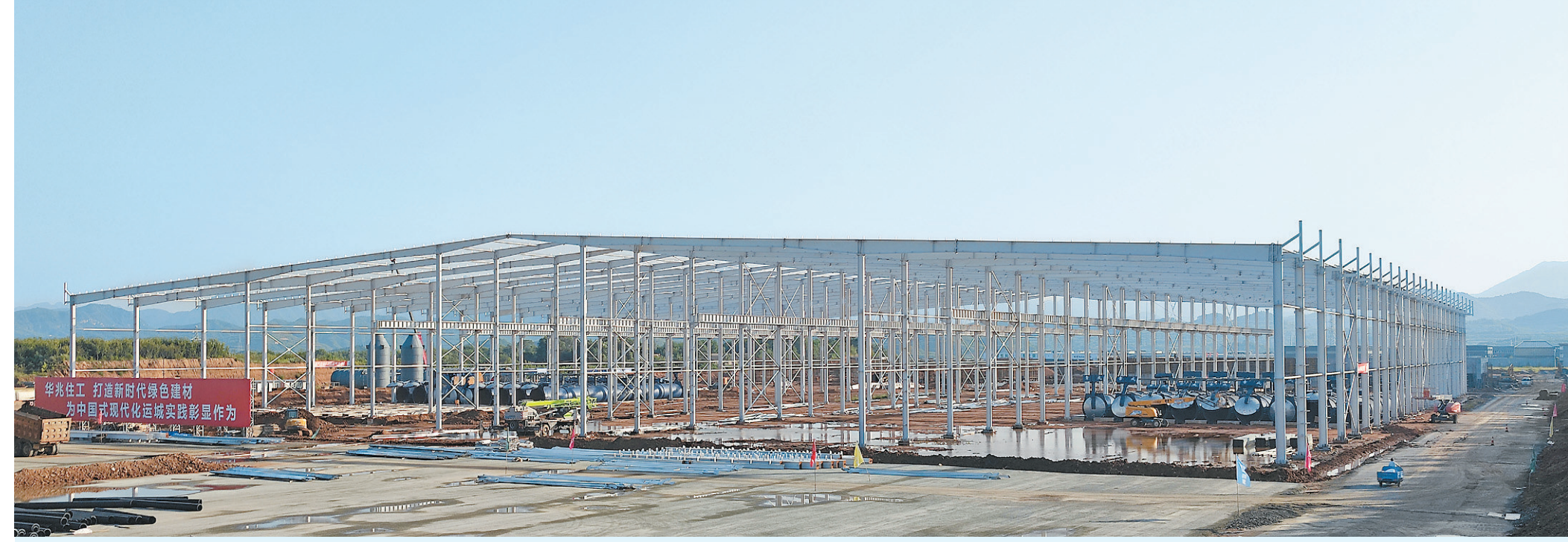
华兆住工ALC装配式建筑新材料项目建设工地。 本报记者 陈永年 摄
