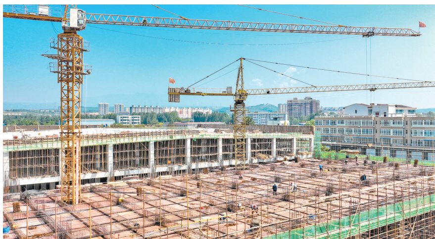
9月6日,山西弘美华农业科技有限公司二期项目工地,工人在加紧施工。
