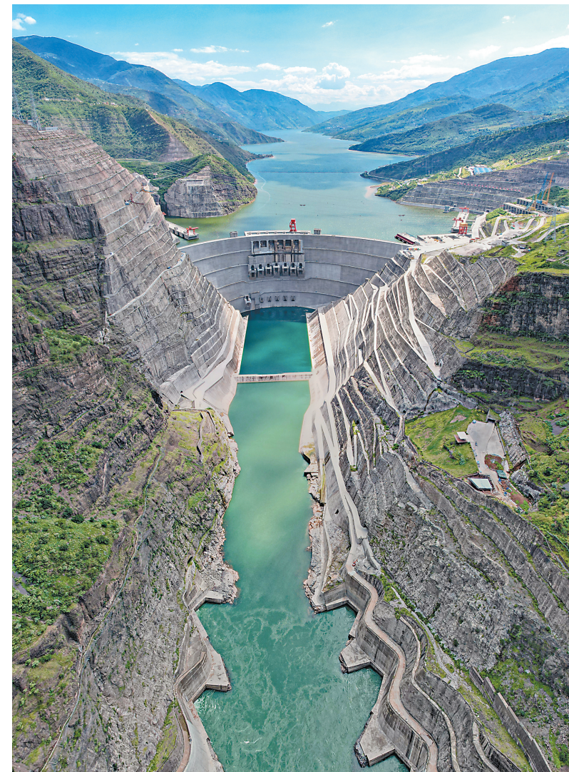
这是9月18日拍摄的白鹤滩水电站一景（无人机照片）。
