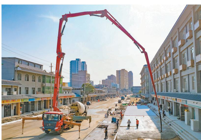
▲9月18日,在中心城区南城街雨污分流及道路提升改造工程现场,工人们在铺设水泥路面。我市持续推进市政排水管网雨污分流改造,今年全市排水管网雨污分流改造任务102千米,截至8月底,累计完成雨污分流改造109.7千米。本报记者 常奇 摄
